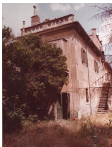
Edificio Principale Fronte Laterale Destro guardando da Via S. Pantaleo Campano (Ante Opera)
