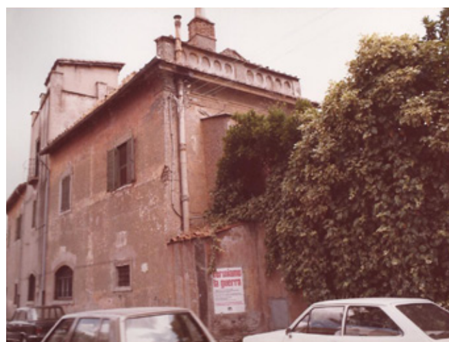
Edificio Principale da Via S. Pantaleo Campano (Ante Opera)
